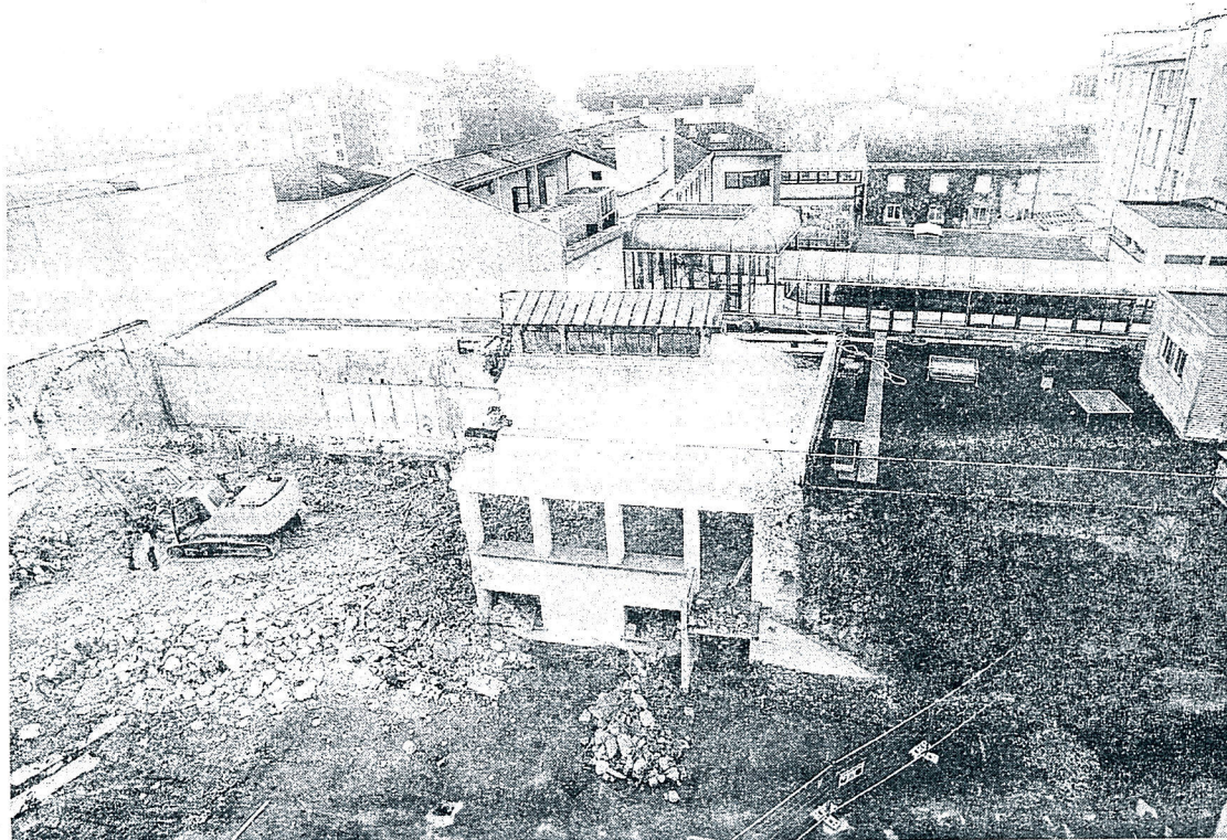
Chantier. Une partie des anciens locaux de la Chambre d'agriculture sera remplacée par le futur bloc opératoire
